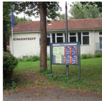
Abbruch Erweiterungsbau Schule ▶ bisherige Nutzung - vhs - Bürgertreff mit Musikschule - Kinderpark - Vereinsräume ▶ Nutzungen müssen neu untergebracht werden
