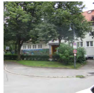
Alte Schule ▶ Erhalt (Ergebnis Bürgerwerkstatt) ▶ schlechte Bausubstanz Modernisierung erforderlich ▶ Verlegung der bisherige Nutzung Jugendzentrum in das leerstehende Postgebäude ▶ neue Nutzung evtl. Musikschule
