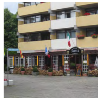
Besteh. Infrastruktur im Bereich Alois-Harbeck-Platz
